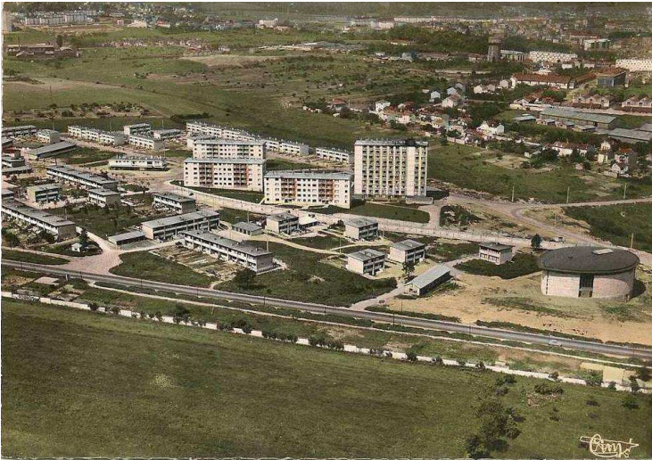
L'église s'impose dans le paysage par son volume simple, ses façades en béton armé brut de décoffrage et sa toiture élancée.
