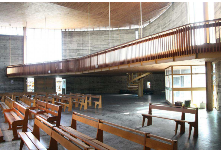
Face à l'autel, la tribune est suspendue à la charpente de la toiture grâce à un système de tubes métalliques.
